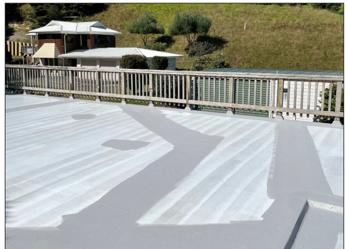
Epistix primer and fibreglass repairs
