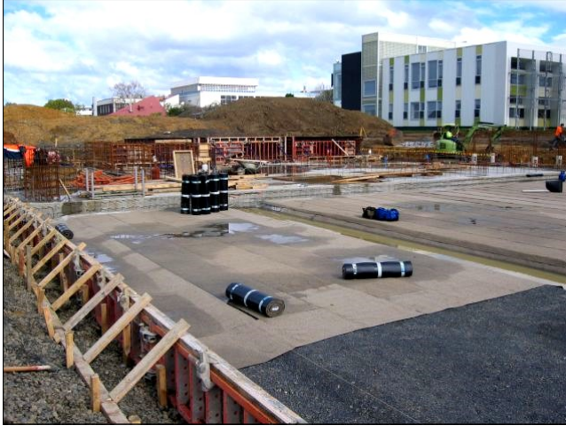
De Boer Debobase loose laid on hardfill
