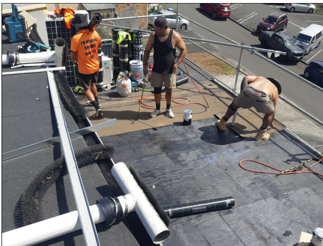
Base sheet torched-on over primer
